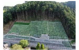
〔道路法面対策〕
