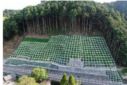
道路法面对策 (国道371号・河内長野市)
