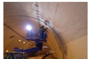
〔トンネル点検〕
