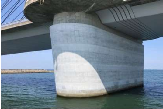
橋脚の補強 (府道泉佐野岩出線・田尻町)
