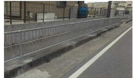
防護柵（横断防止柵）の設置（貝塚市）
