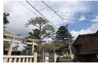
電線による景観阻害
