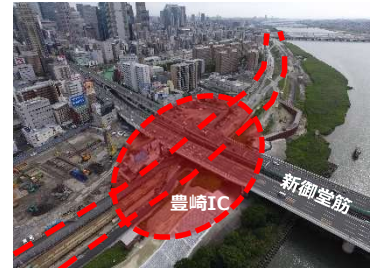
淀川左岸線 ((仮称)豊崎IC)
