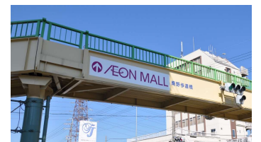
国道170号 南野歩道橋（四條畷市）
