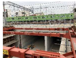
〔道路と鉄道の立体交差〕
