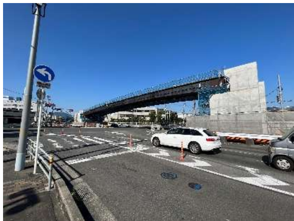
道路との立体交差化 (〔都〕茨木寝屋川線と国道171号・茨木市)
