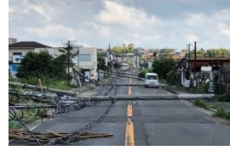
倒壊による道路閉鎖
