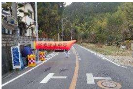
空気式遮断機による通行規制 (府道岸和田牛滝山貝塚線・岸和田市)
