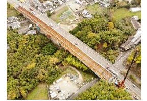
〔道路の整備（4車線化）〕
