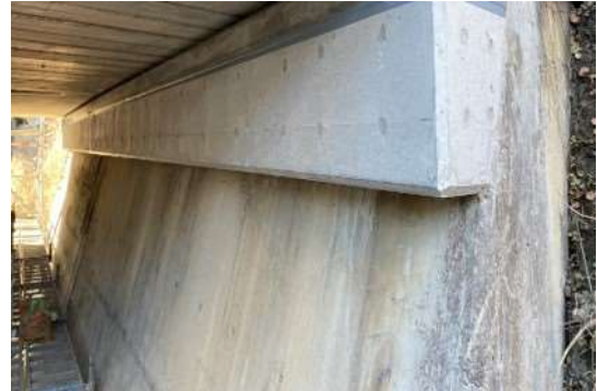
落橋防止対策 (国道423号・豊能町)
