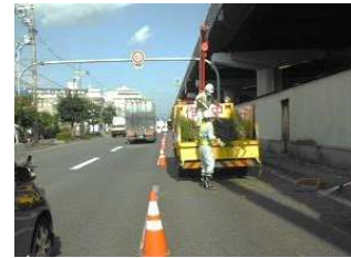
道路施設の清掃
