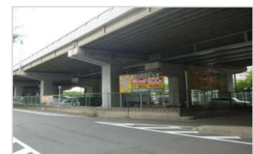
国道423号榎坂高架橋下 （吹田市）
