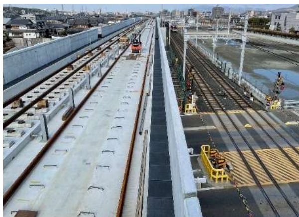
鉄道との立体交差化 (府道美原太子線と近鉄長野線・富田林市)
