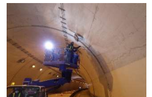
〔トンネル点検〕
