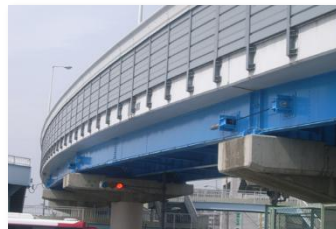
落橋防止対策
