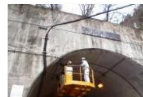
〔トンネル点検〕
