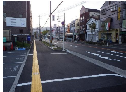
視覚障がい者誘導用ブロック設置
