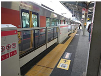
可動式ホーム柵の設置（扉式）
