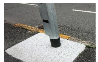
道路照明灯の更新
