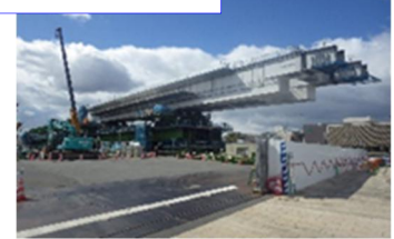
高架区間 桁架設状況
