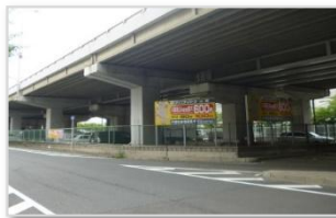
▲国道423号榎坂高架橋下 (吹田市)
