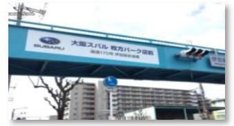
▲一般国道170号 伊加賀歩道橋(枚方市)
