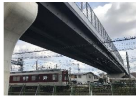
〔道路と鉄道の立体交差〕
