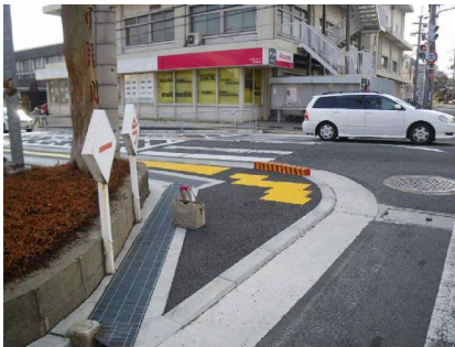
段差、勾配の改善
