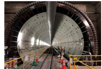
シールド区間 内部施工状況
