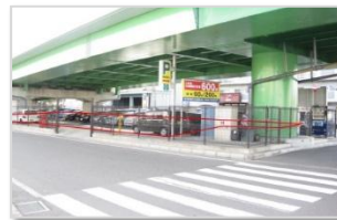
▲国道170号新町跨道橋高架下 (東大阪市)
