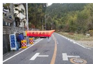
空気式遮断機による通行規制
