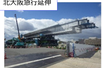
高架区間 桁架設状況
