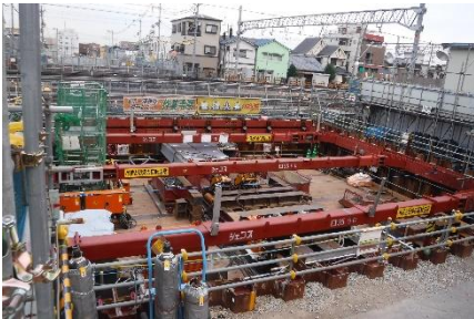
道路と鉄道の立体交差化 (〔都〕大泉本郷線・柏原市)
