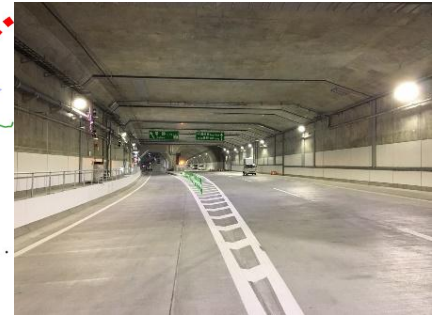
阪神高速 大和川線 (令和2年3月供用)
