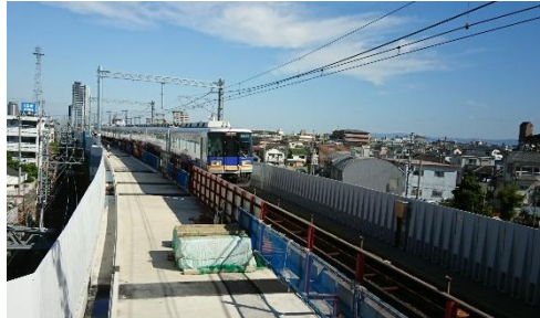
連続立体交差化 (南海本線・高師浜線・高石市)
