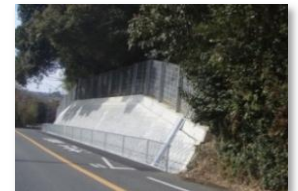
〔道路法面对策〕
