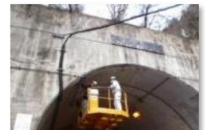
〔トンネル点検〕
