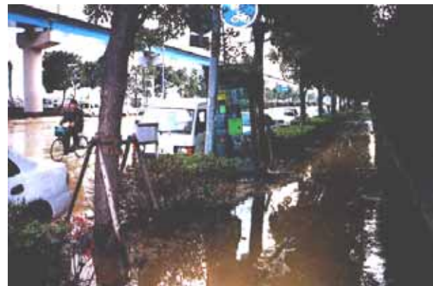
写真 2 液状化現象の一例（歩道部）
