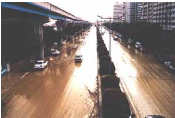
写真 1 液状化現象の一例（車道部）
