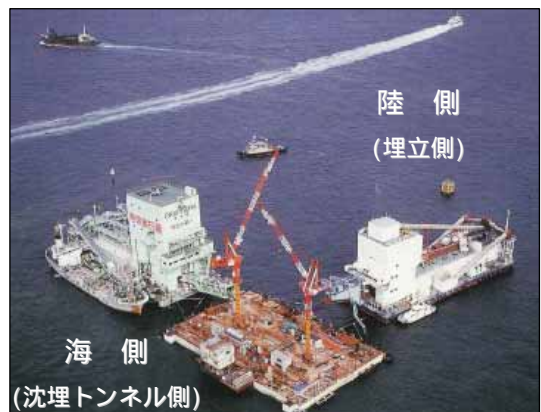
写真2 コンクリート打設の状況
