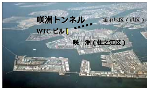
図 1 咲洲・WTC ビルと咲洲トンネル
