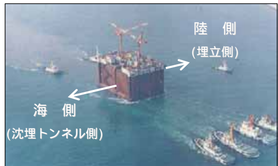
写真1 ケーソン曳航の状況
