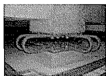
③ 鋼材ダンパー 鋼材の復元力を利用し建物の揺れを早く収める
