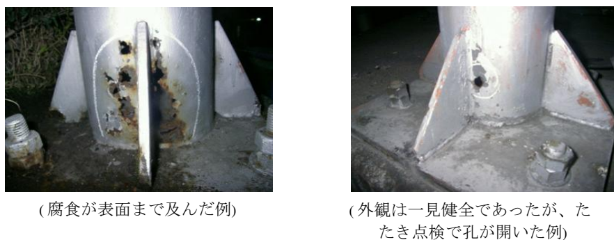
図5-3 照明柱、標識柱等の柱基部
