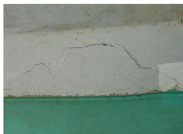
(モルタル片剥落前；定期点検時)
