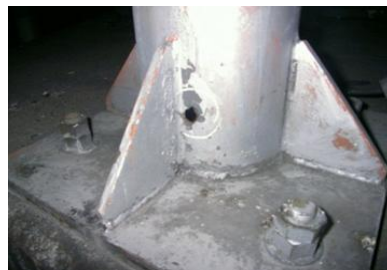
(外見は一見健全であったが、たたき点検で孔が開いた例)
