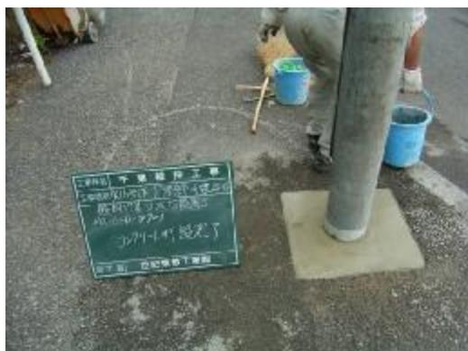
図付 11-2 水切りコンクリートの施工事例
