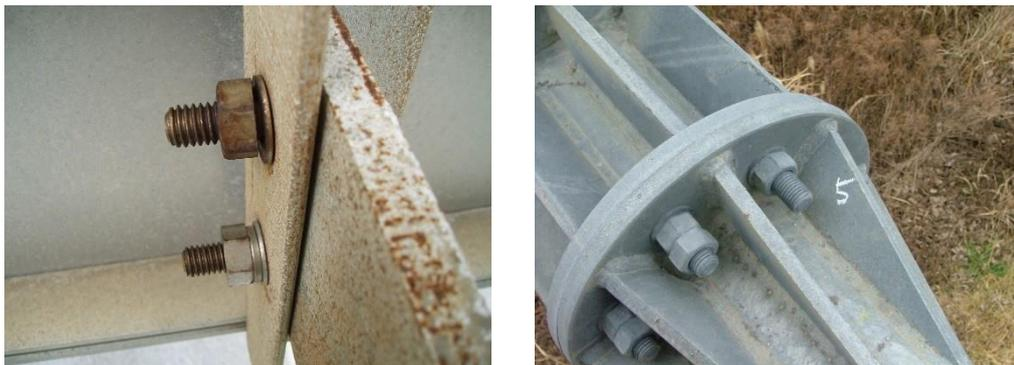
図 8-11 設置後 10 年以内の附属物の変状事例
