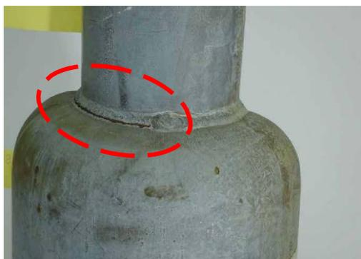
照明柱断面変化部の溶接に確認された亀裂
