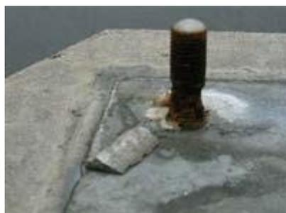
図 6-2 転用部材のアンカーボルトの変状事例
