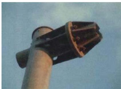
標識横梁基部の破断による標識板落下
