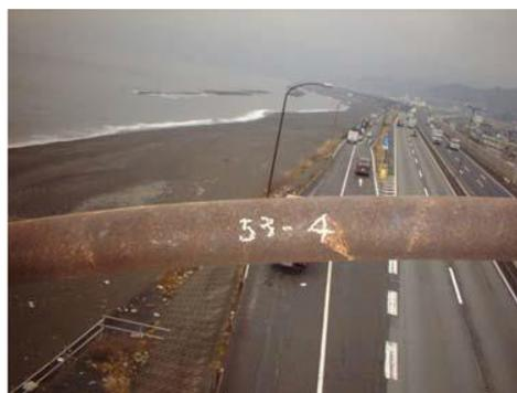
図 8-22 支柱本体の腐食事例
