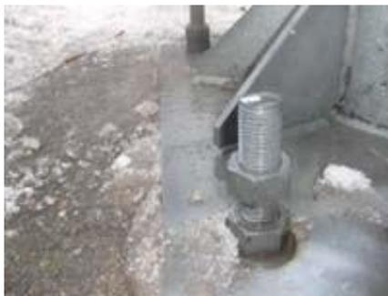
図 6-1 設置後 1 年程度の附属物のアンカーボルトのゆるみ
