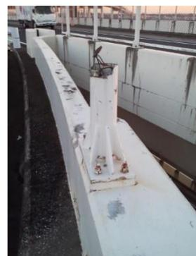
図 8-6 支柱の断面変化部や開口部の亀裂による変状事例
