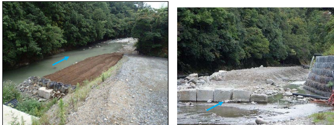
写真 2-1 置き土（人工盛土）の設置状況（左：R2年度置き土、右：R3年度置き土）
