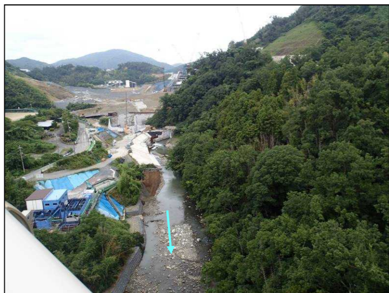
写真 2-1 置き土（人工盛土）の設置状況（遠景）
