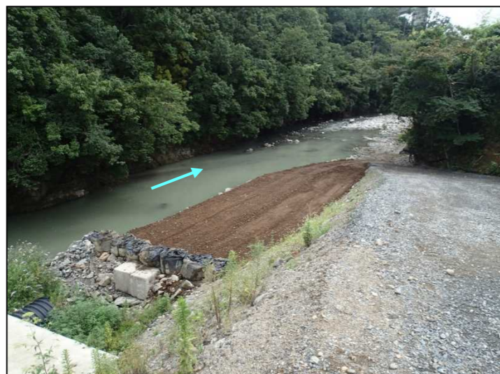
写真 2-2 置き土（人工盛土）の設置状況（上流より）
