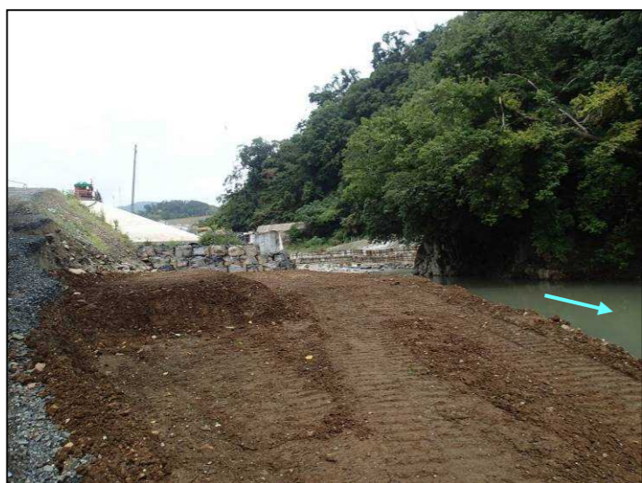
写真 2-3 置き土（人工盛土）の設置状況（下流より）
