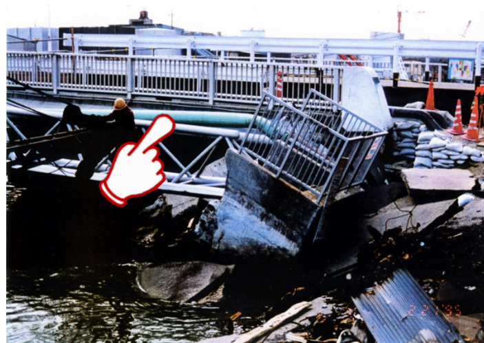
阪神・淡路大震災で落下した橋梁に併設されていた中圧供給管 (当社撮影)
