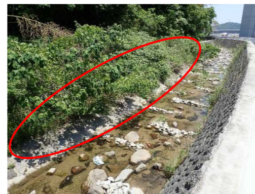
緩傾斜護岸の造成 ([redacted]の避難経路の設置)
