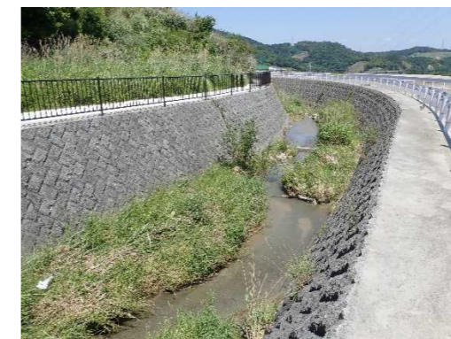
カゴマットの設置（寄洲、植生帯の創出）
