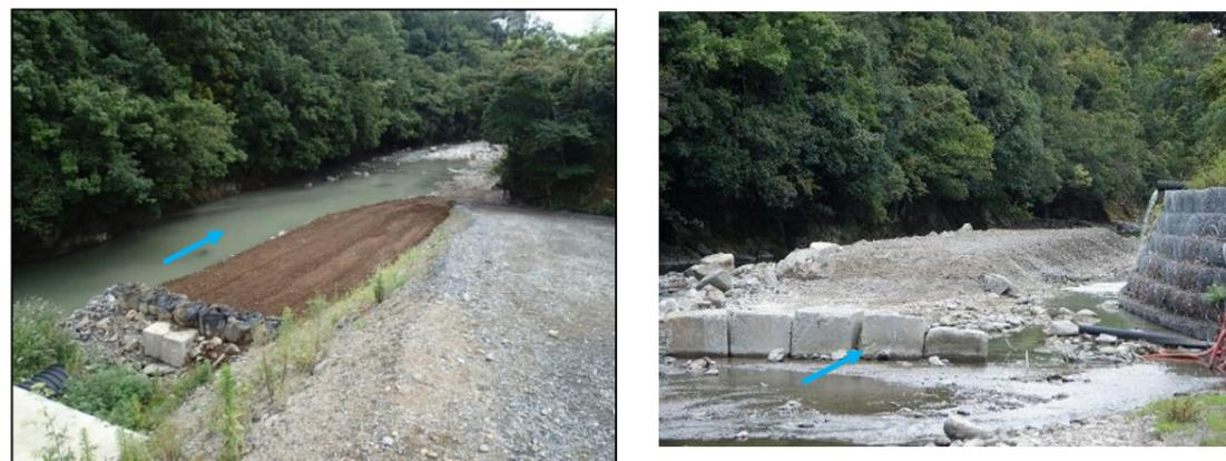
写真 1-1 置き土（人工盛土）の設置状況（左：R2年度置き土、右：R3年度置き土）
