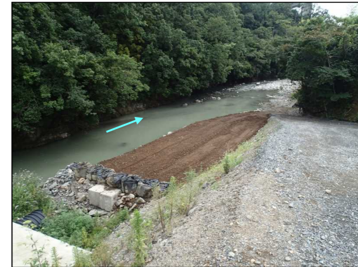
写真 3-2 置き土（人工盛土）の設置状況（上流より）
