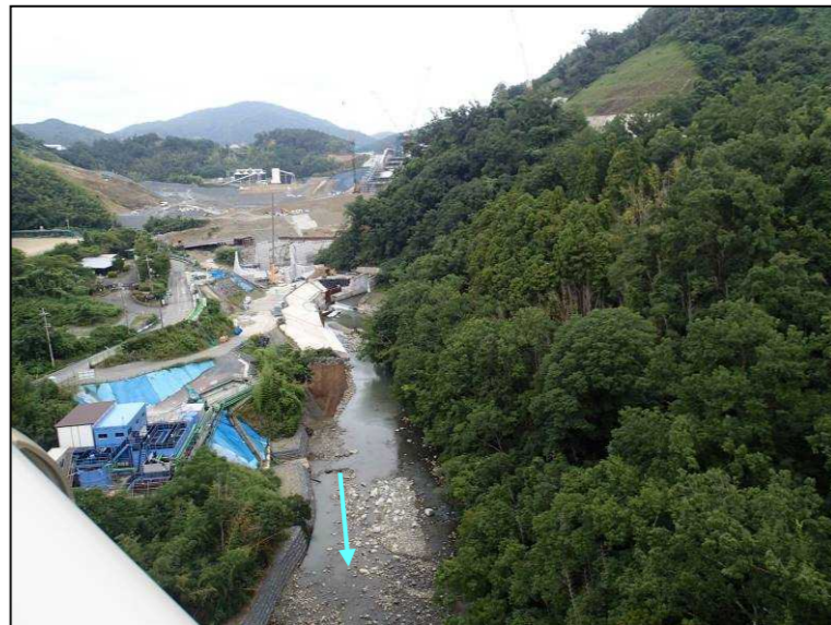
写真 3-1 置き土（人工盛土）の設置状況（遠景）
