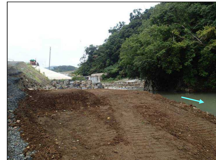
写真 3-3 置き土（人工盛土）の設置状況（下流より）
