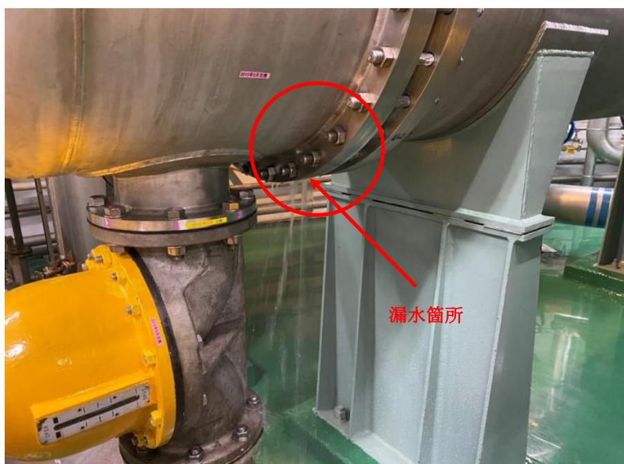
写真2 漏水時の熱交換器 No.2
