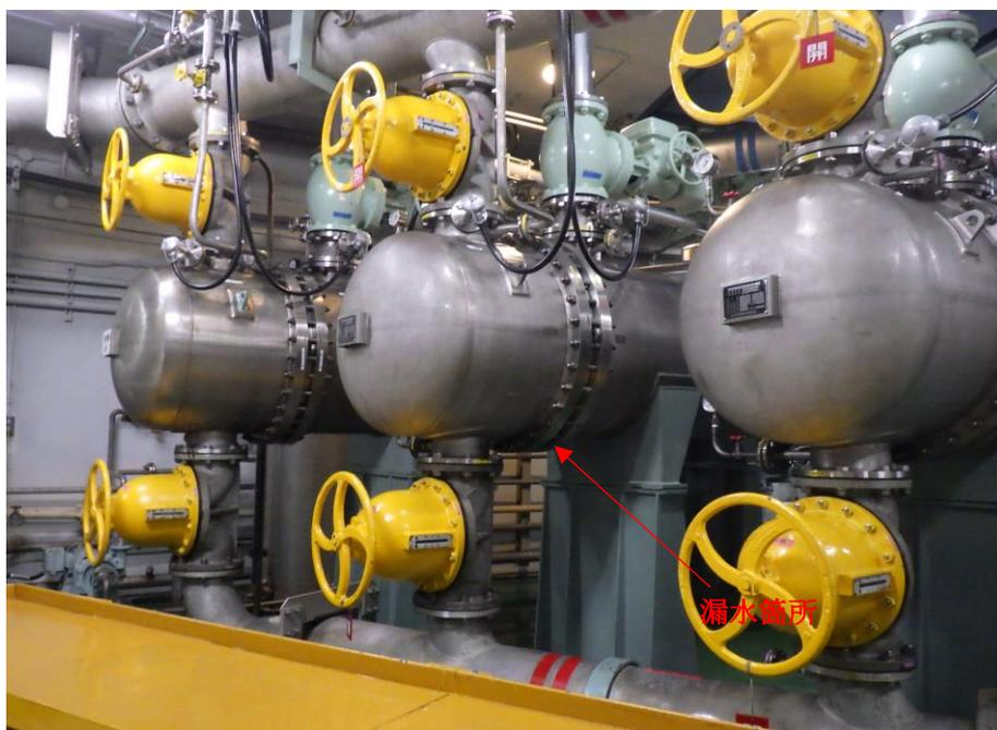
写真1 熱交換器 No.1、No.2、No.3
