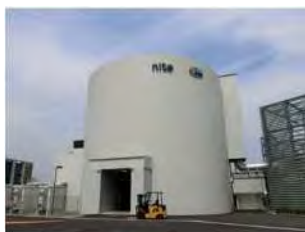
多目的大型実験棟
