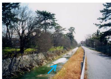
②高川（高川水路橋下流）
