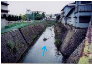
①大正川（春日橋下流）
