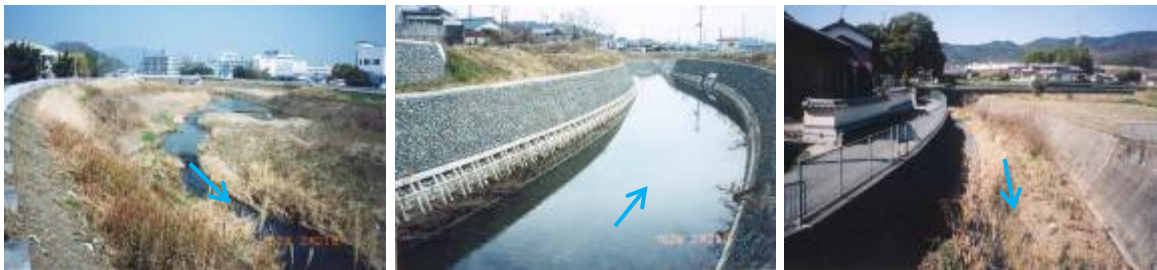
①茨木川（上野橋上流）
