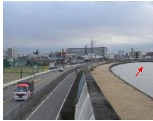
写真 1.4 防潮堤状況 (神崎川：左門殿川分派後)
