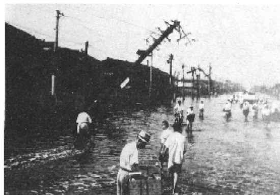
写真 1.1 浸水状況 (国道 2 号)
