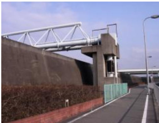
写真 1.5 防潮堤状況 (神崎川：出来島大橋下流)
