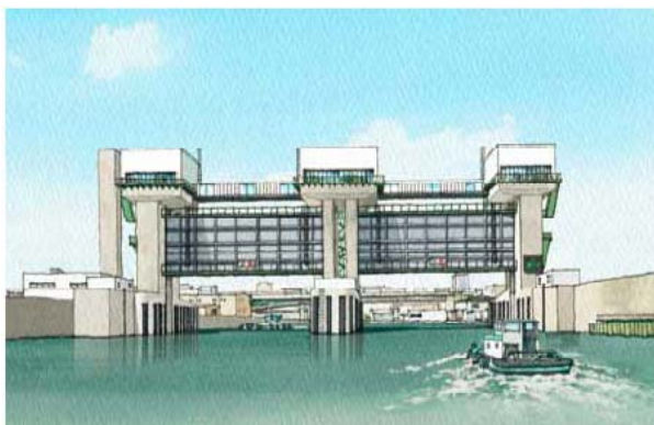
下流側より 新木津川水門の構造形式（完成イメージ②）
