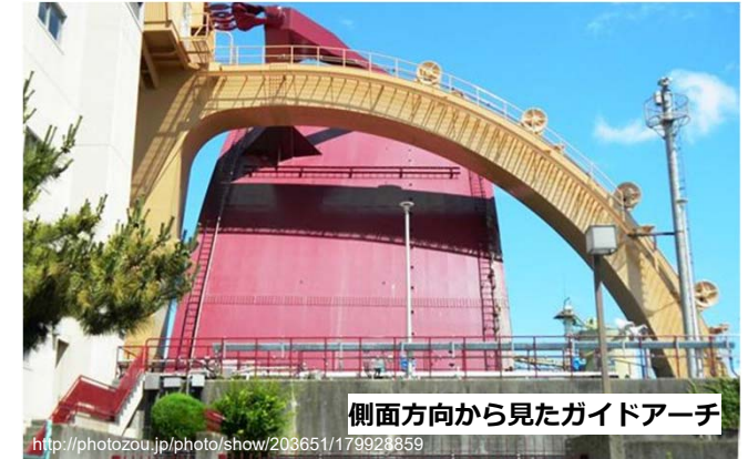
稼働中の安治川水門
