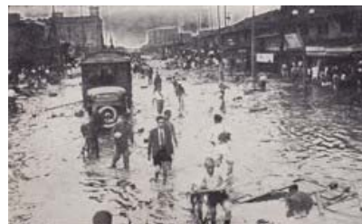
第2室戸台風による浸水被害
