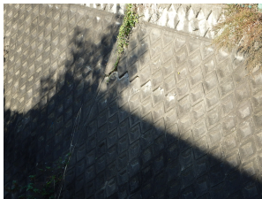
護岸損傷
