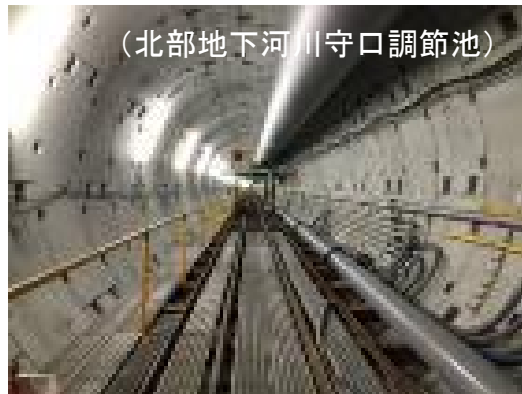
地下河川・流域調節池整備
