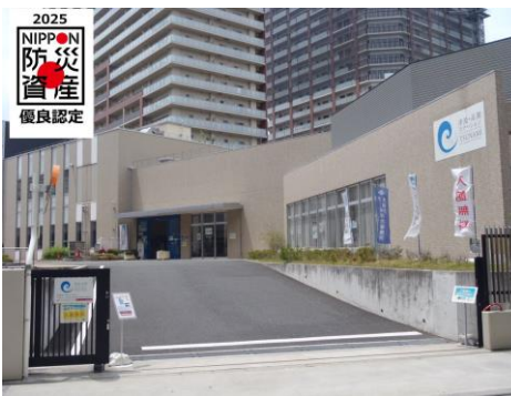
津波・高潮 ステーション
