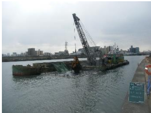
神崎川河床掘削工事
