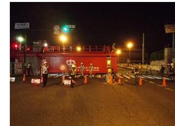
防潮堤点検操作訓練（左門橋）
