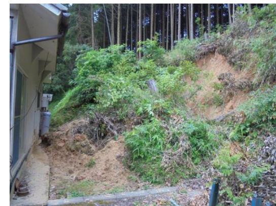
◆災害報告の事例（河内長野市日野）
