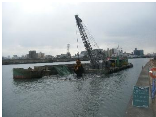
神崎川河床掘削工事
