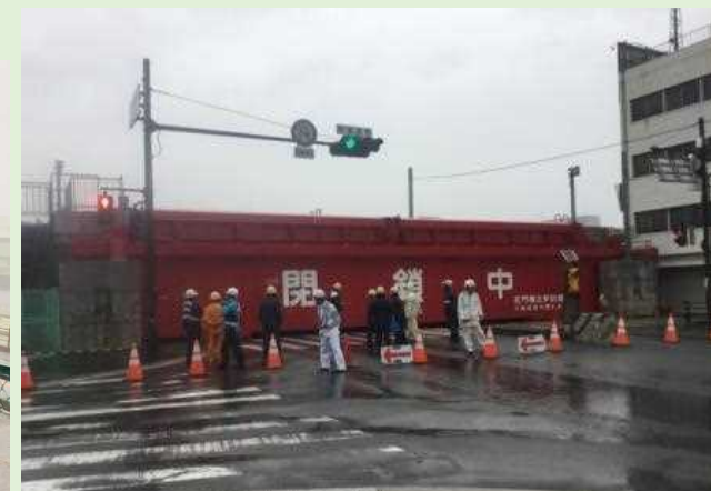
左門橋左岸 (左門殿川)
