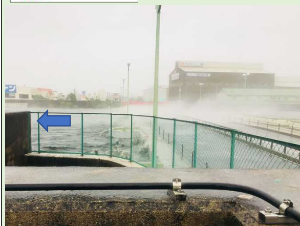
鉄扉閉鎖時の左門殿川の様子
