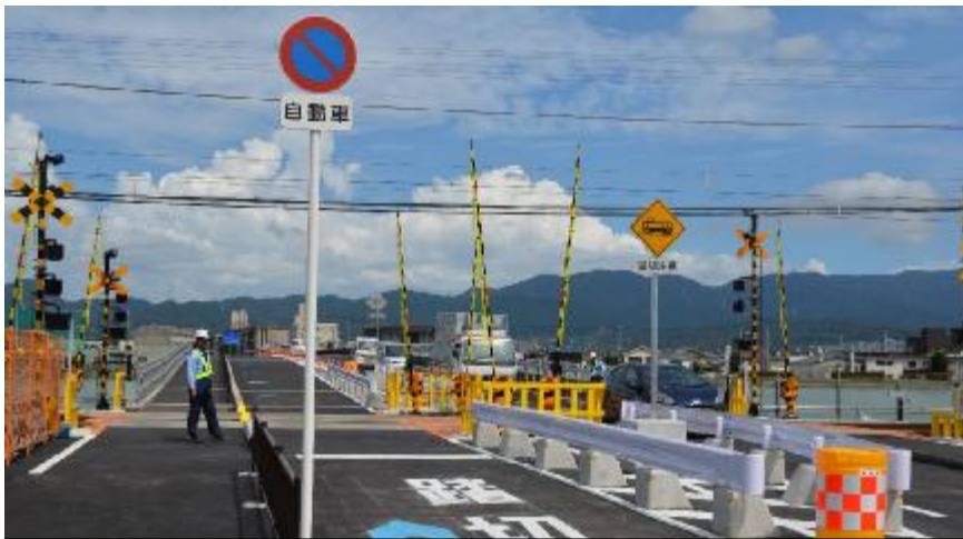
仮線切替後(府道・暫定踏切)
