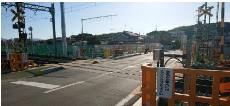
仮線切替後(市町村道・踏切)
