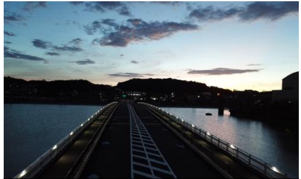
バイパス道路完成(高欄照明) 〈令和元年8月 供用開始〉
