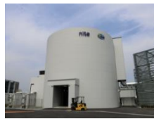
■多目的大型実験棟
