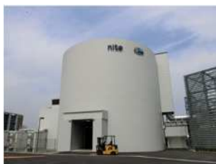
多目的大型実験棟
