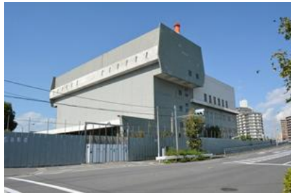
解体が滞るゴミ処理場
