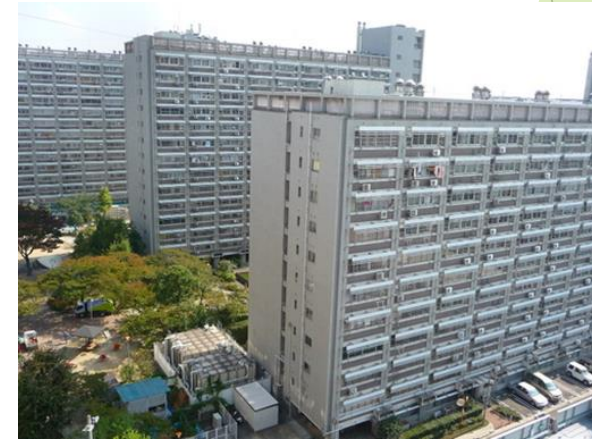
老朽化が進む森ノ宮団地
