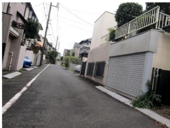
写真1 陥没箇所の事前状況写真(2020年7月30日)
