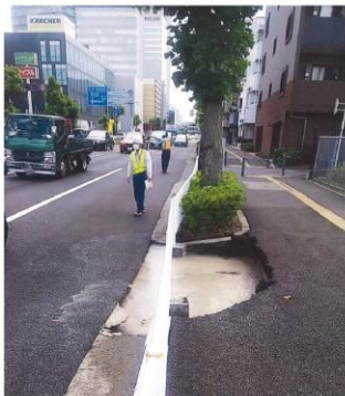
写真-1 新綱島側より（15:00頃）
