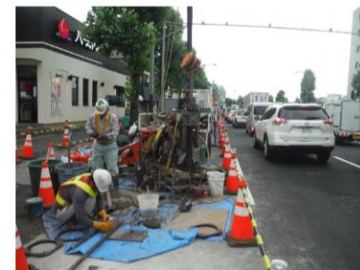
写真-6 7/1 注入作業状況
