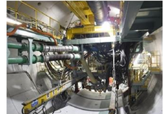
①本掘進 掘進状況 (坑内切羽)
