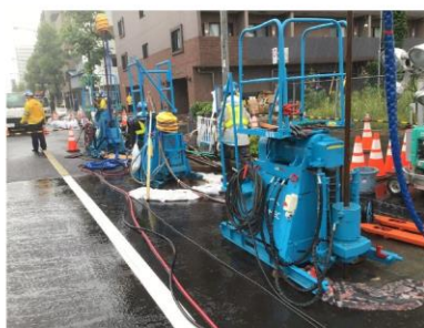
写真-6 6/13 注入作業状況
