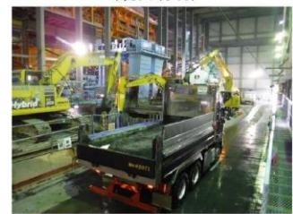
②掘削残土 土砂積込状況 (泥水ヤード)
