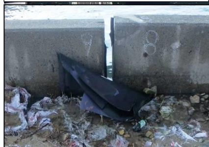
写真① 護岸上部目地開き
