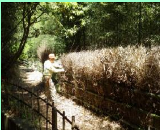
施設の維持(柵の補修)
