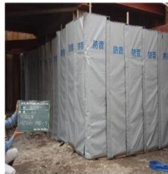
防音シートによる騒音対策
