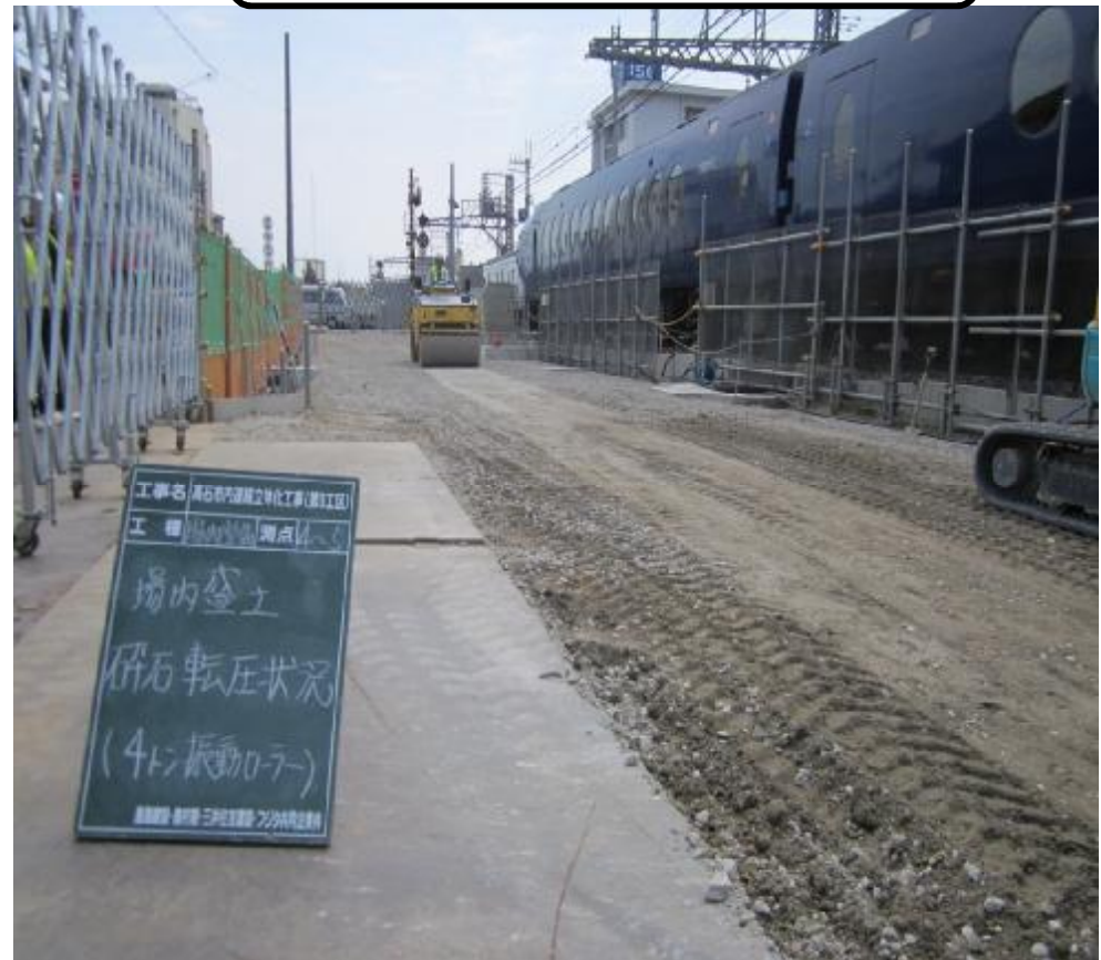
盛土による工事ヤード整備
