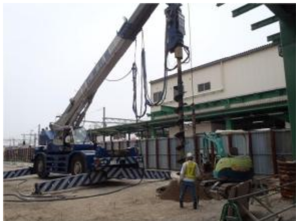
鋼矢板打設工法変更 (オーガ併用圧入⇒先行削孔+圧入)
