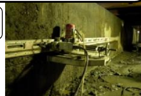
ワイヤーソーによる取壊し
