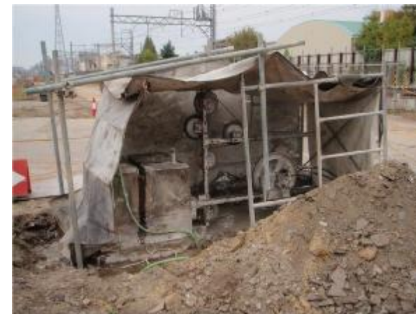
コンクリート撤去方法 (はつり⇒コア抜き、ワイヤーソー)
