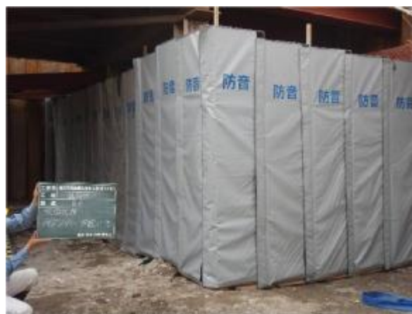
杭頭処理(防音シート設置)
