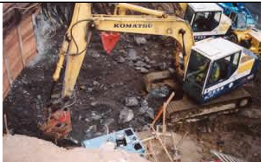
大型ブレイカーによる取壊し
