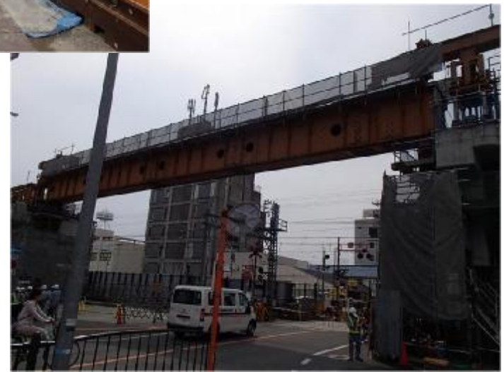
PC桁架設工法変更（直接架設⇒が-た-架設） 24
