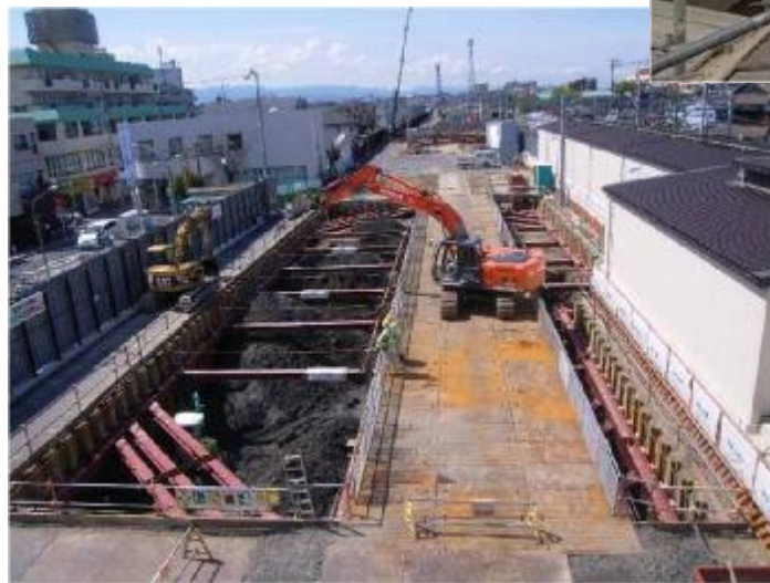
仮設棧橋設置・撤去
