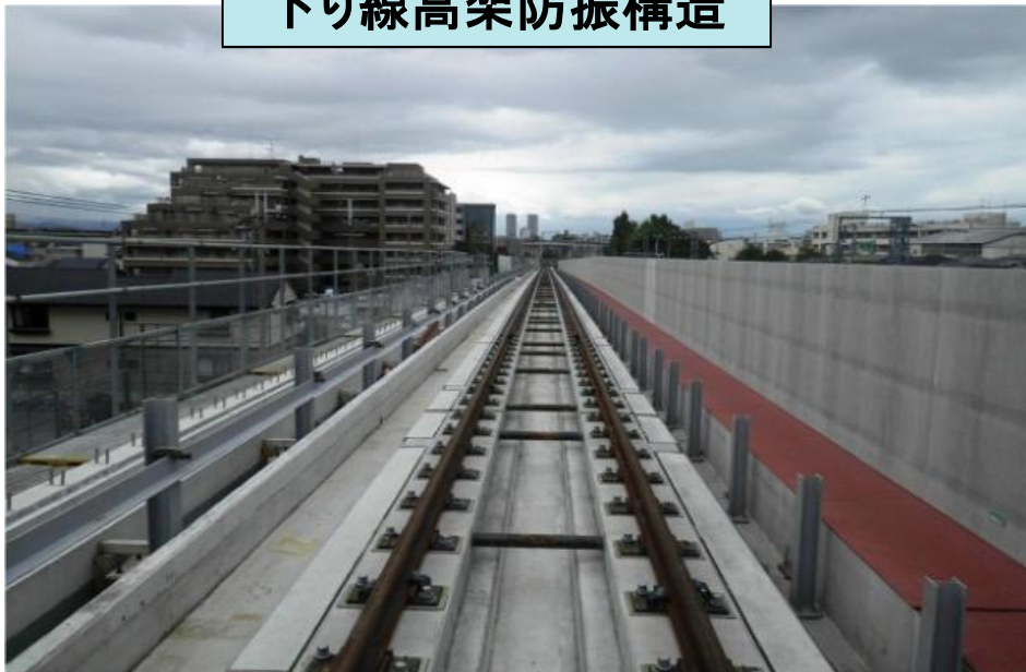
下り線高架防振構造
