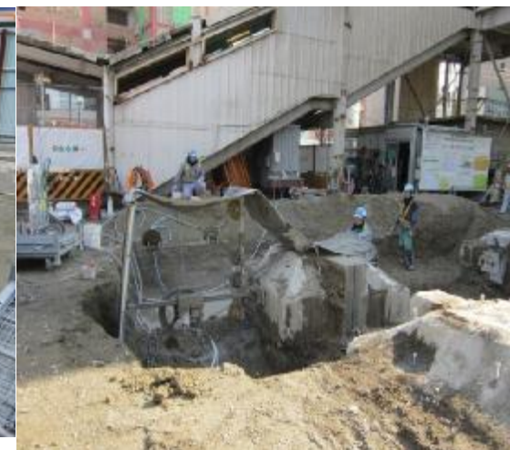
ワイヤーソーによる取壊し
