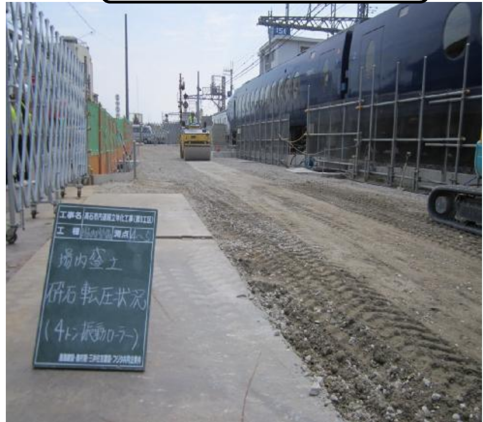
盛土による工事ヤード整備
