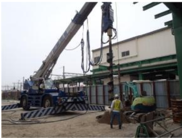
鋼矢板圧入工法変更 (オーガ併用圧入⇒先行削孔+圧入)
