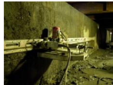
ワイヤーソーによる取壊し
