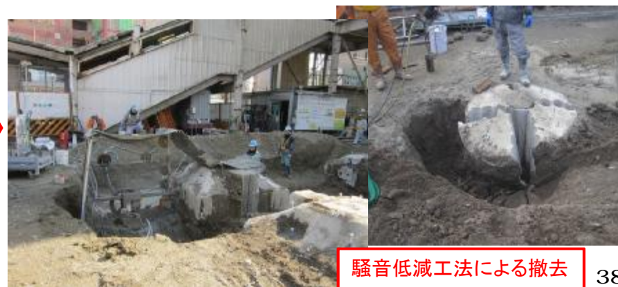
ワイヤーソーによる取壊し
