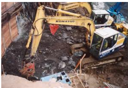
大型ブレーカによる取壊し
