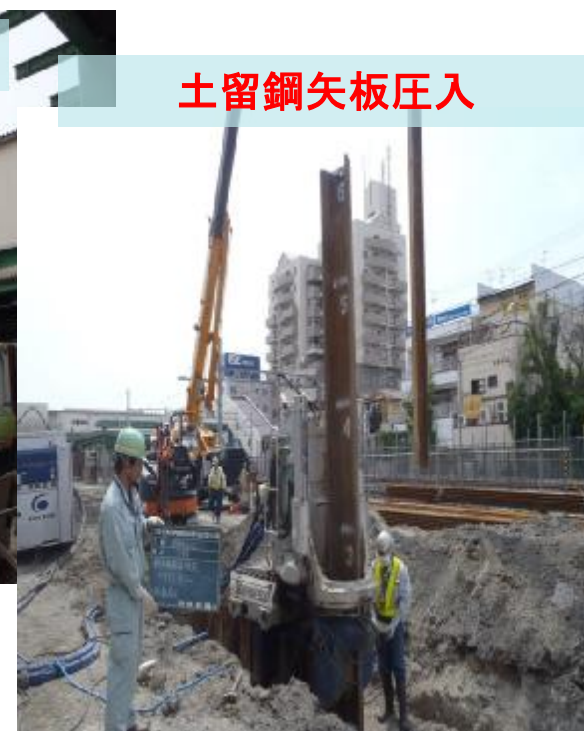
サイレントパイラー
