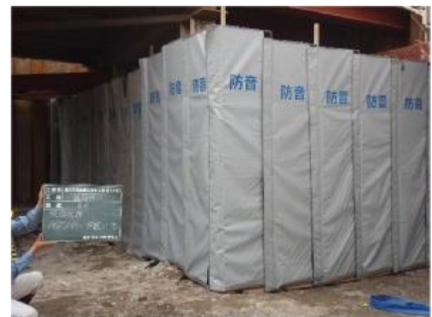
杭頭処理(防音シート設置) 35
