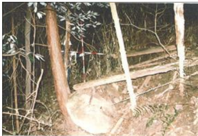
■山腹崩壊状況
