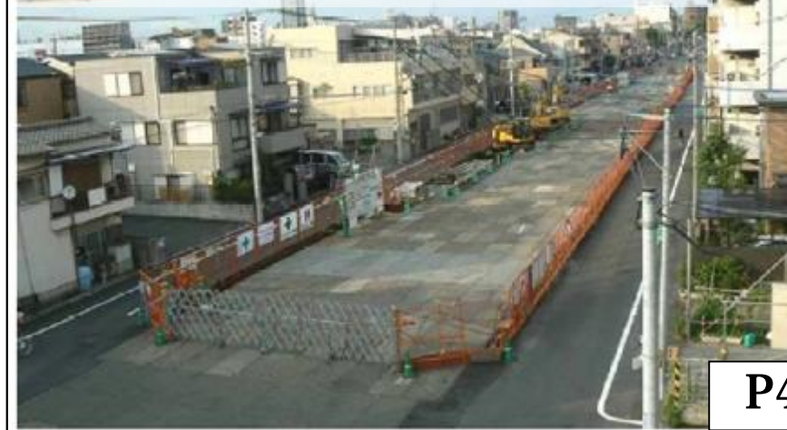
鉄道より東側 (地盤改良工施工中)
