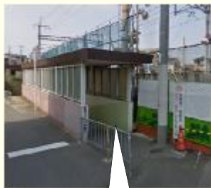
スロープ入口
