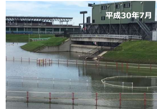
恩智川(花園)多目的遊水地の貯留状況
