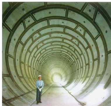
寝屋川北部地下河川 (古川調節池)
