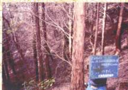
本数調整伐・枝落とし（施工中）
