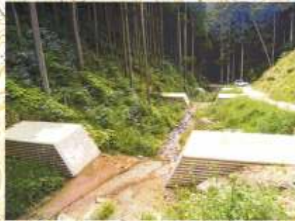
治山堰堤工施工後の状況 （上流から下流を望む）
