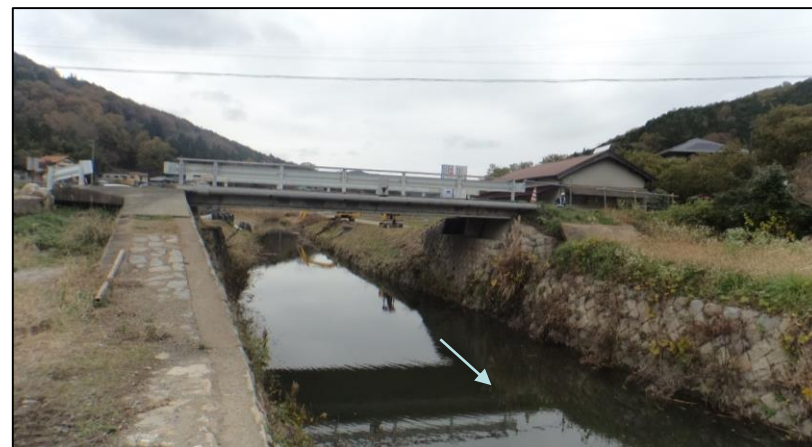
中田橋改築前
