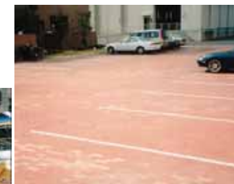
アシュレン施工事例 (駐車場整備:大井水みらい センター)
