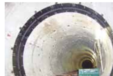
可とう継手(可とうセグメント)の設置
