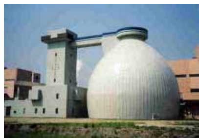
卵形消化槽 (原田水みらいセンター)
