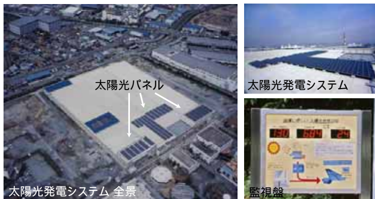
太陽光発電システム 300kW (中央水みらいセンター)
