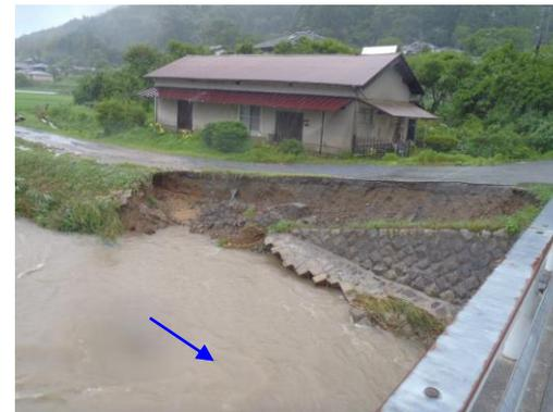
中田橋上流 護岸の被災
