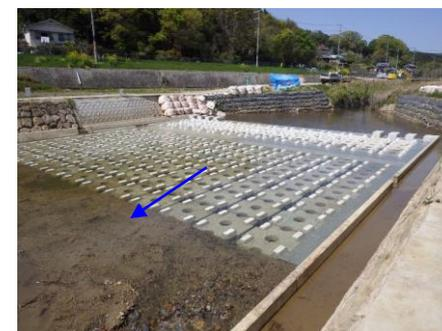
上下流連続性に配慮した緩傾斜式落差工の整備状況
